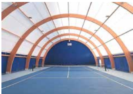
Il terzo campo con copertura permanente
