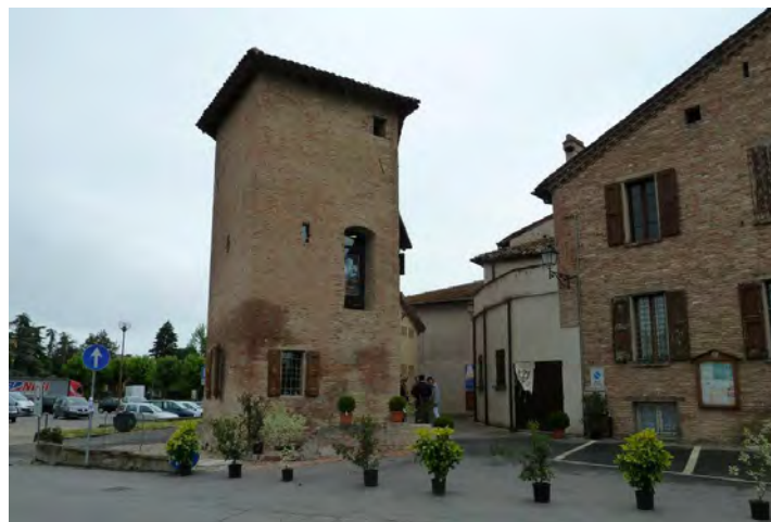
Torre Borgo vecchia sede
